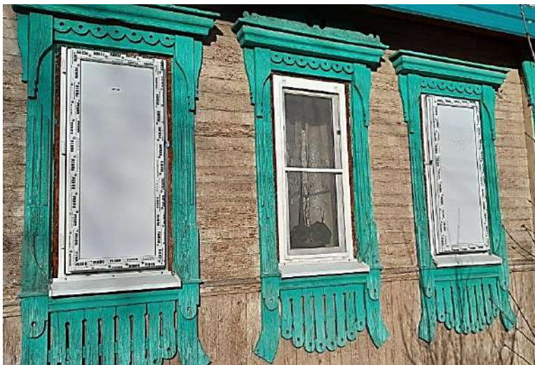
Рис. 1. Энергоэффективные ставни с теплоотражающими экранами, установленные на оконные блоки жилого дома
