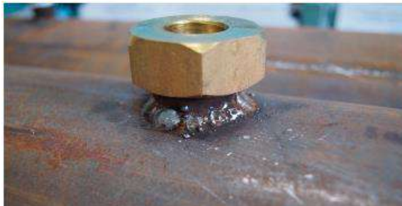
Рис. 3. Способ крепления дисков на трубопроводе: вид сбоку
